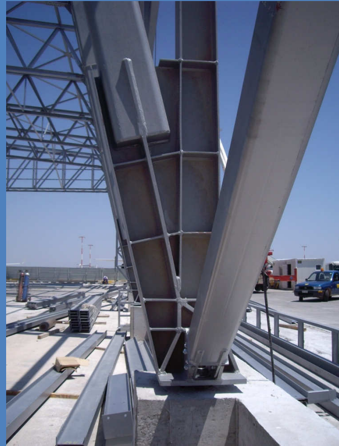
Έδραση πλαισίου (θέση συνδέσμου δυσκαμψίας)
