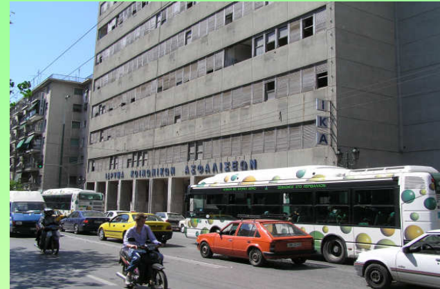
Όψη από την οδό Πειραιώς
